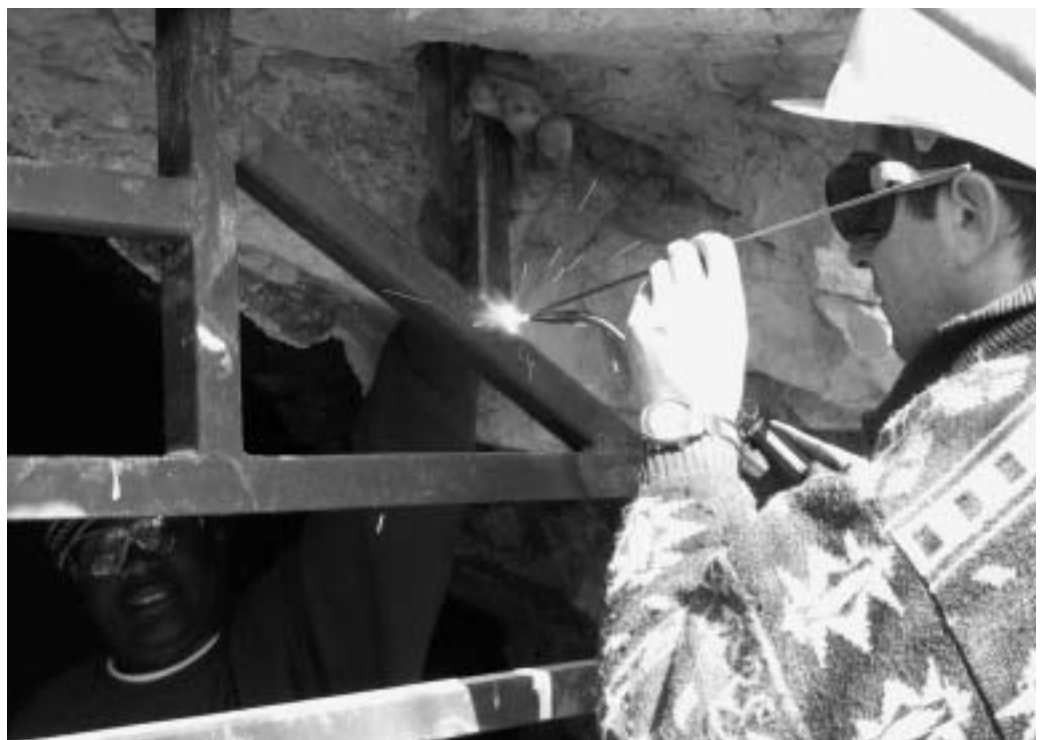
Fermeture d'une cavité par une grille
