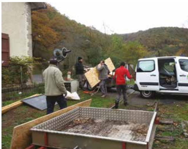
▲ Travaux de restauration à Saint-Illide
