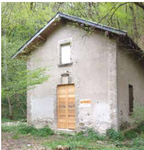
▲ Abri SNCF de Saint-Illide
