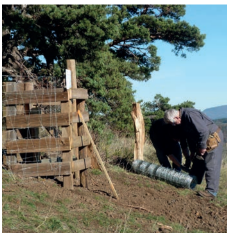
▲ Pose d'une chicane (Polignac)
