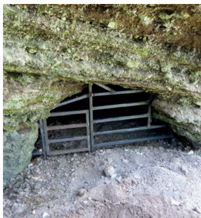
▲ Grille installée à l'entrée d'une galerie
